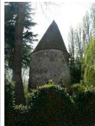
17- Tourelle de l'ancien château rue de la Prairie
